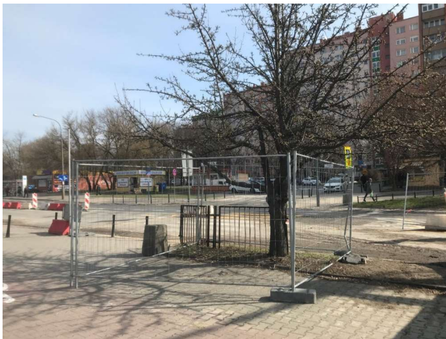
Fot. 2 Przykład wygrodzenia drzew z terenu budowy w Strefie Ochronnej Zieleni (fot. IGR, 2022r.)
