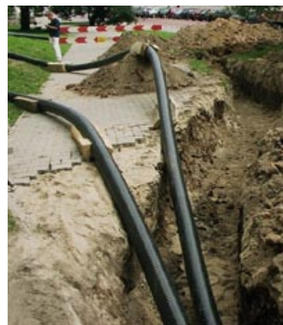
Fot. 3. Giętka rura preizolowana układana w wykopie
