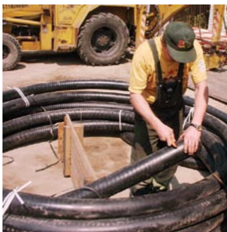
Fot. 2. Giętka rura preizolowana przed montażem
