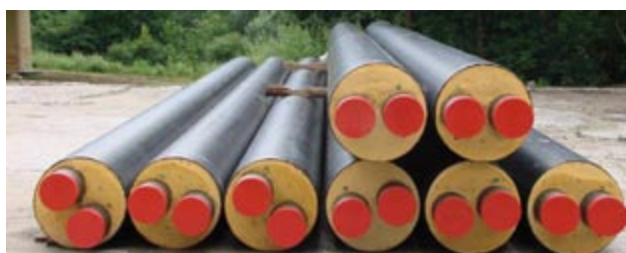
Fot. 4. Rury preizolowane podwójne składowane na placu budowy
