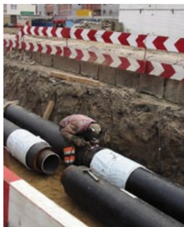
Fot. 1. Montaż tradycyjnych rurociągów preizolowanych
