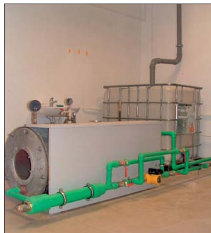
Fot. 8 Stanowiska do badania szczelności złącza preizolowanego po badaniu w skrzyni z piaskiem
