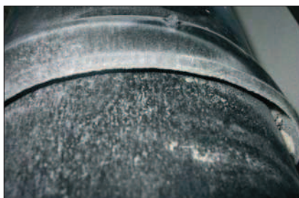
Fot. 2 Mufa zgrzewana elektrycznie po badaniu obciążenia od gruntu 100 cyklami – po próbie nieprzepuszczalności wody okazało się, że jest nieuszczelniona, powodem nieuszczelnienia było niedokładne zgrzanie mufy
