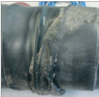
Fot. 4 Nasuwka z HDPE po badaniu obciążenia od gruntu 100 cyklów – zniszczeniu, na skutek niewłaściwego doboru materiału, uległy opaski termokurczliwe – ze względu na podwójne uszczelnienie po badaniu nieprzepuszczalności wody nasuwka była szczelna
